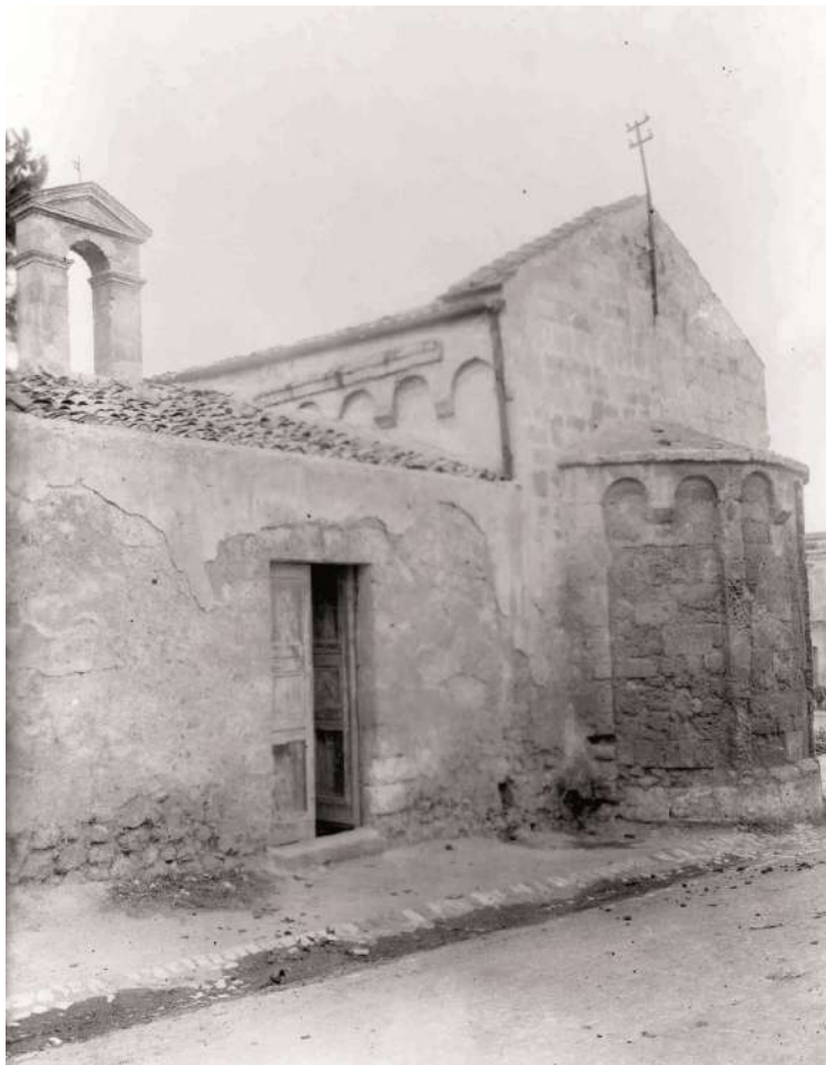
Foto 4. La chiesa prima della demolizione: abside
