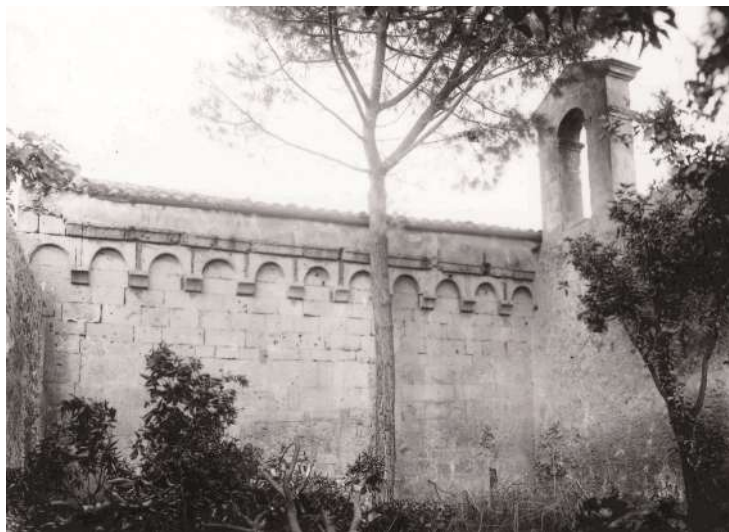
Foto 3. La chiesa prima della demolizione: fianco settentrionale verso il cortile
