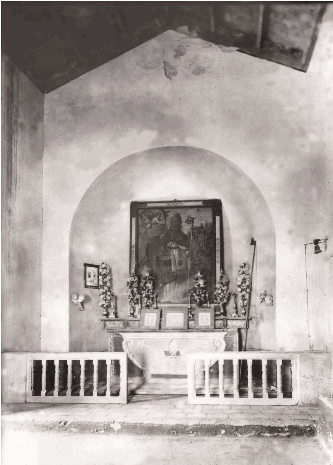
Foto 5. La chiesa prima della demolizione: interno
