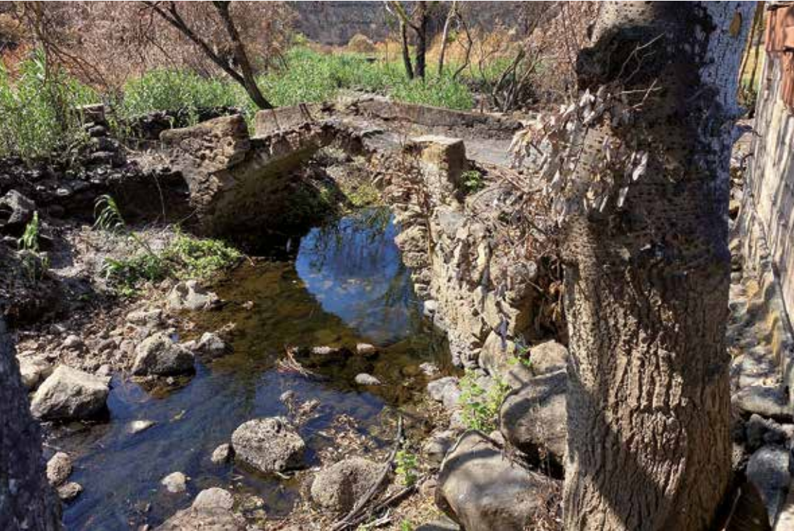
Fig. 51. Ponte don Jaime Tresnuraghes-Sennariolo a Rio Mannu.
