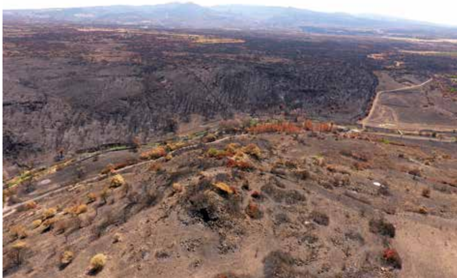
Fig. 53. Nuraghe Maltine, messo a nudo dal passaggio del fuoco. Crolli e degrado delle strutture sono accentuati dalla distruzione della vegetazione.
